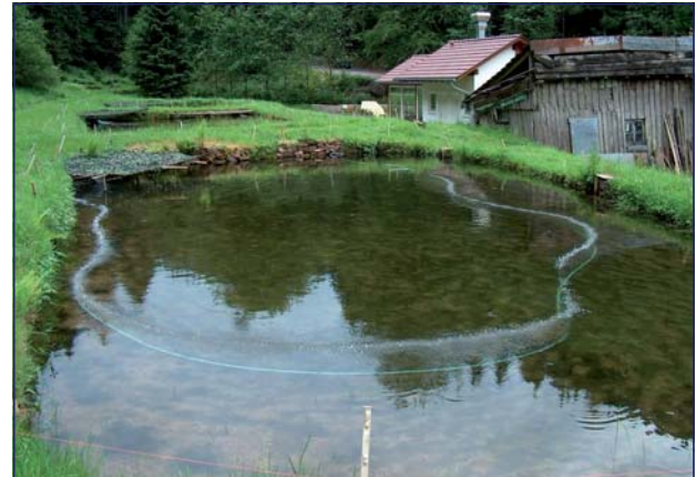
Ein „gekippter“ See wird mit dem DRAUSY-System saniert. Die feinblasige Belüftung auf dem Grund des Gewässers mineralisiert organischen Schlamm und wandelt anaerobe Milieus in aerobe Milieus um. Der See kann wieder „atmen“... und die Fische auch.
